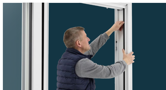
Schritt 4 Profil in der Aufnahmenut der Zarge mit Hilfe der vorgefertigten Clipsaufnahmen befestigen (rastet hörbar ein). Das Plissee des InScreen kann nun leichtgängig geöffnet und geschlossen werden.
